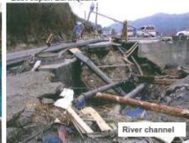
水道産業新聞社：平成23年東日本大震災による水道施設の被害写真集
