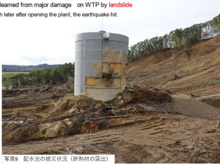
写真9 配水池の被災状況（断熱材の露出）
