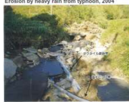
日本水道新聞社：平成16年台風による水道施設の被害写真集
